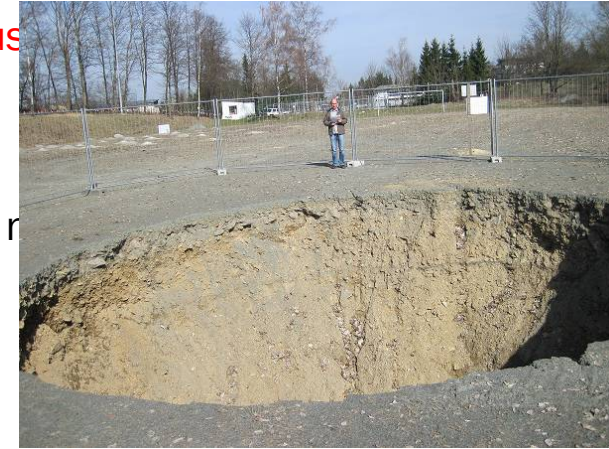
Bergschaden auf dem Sportplatz von Kupferberg (Ofr.) - Der Bruch auf dem St. Veits-Schacht ist rund 30 Meter tief Quelle: StMWIVT
